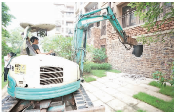
工作人员拆除一楼加建围墙。
