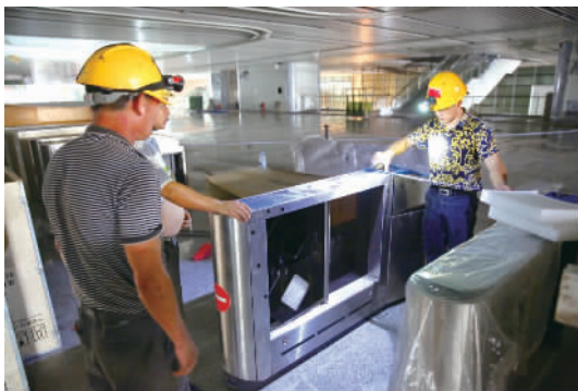
站场内,工人正在抓紧时间施工。
