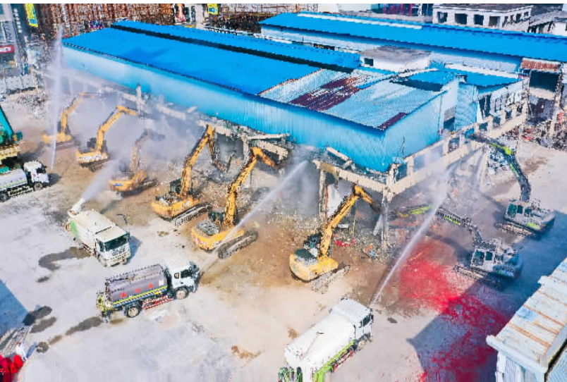
■钜隆家居广场（一期）动工建设。
