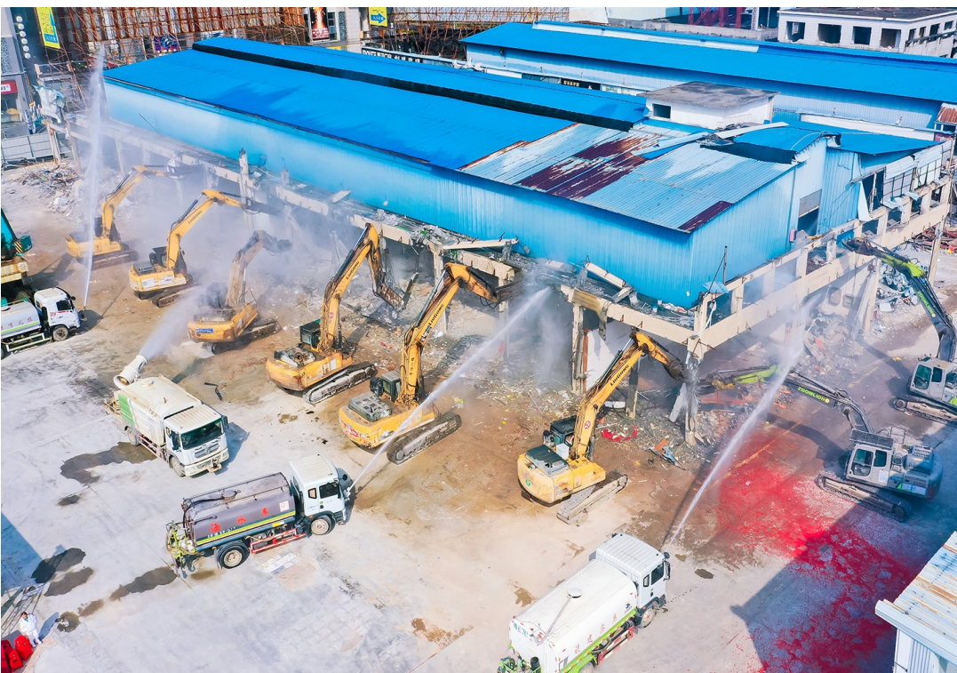
■盐步家具城改造项目动工拆除。
