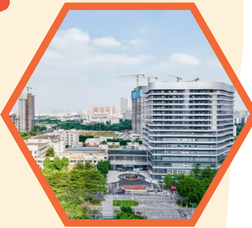
▲广东省人民医院南海医院心血管病大楼启用。(资料图片)
