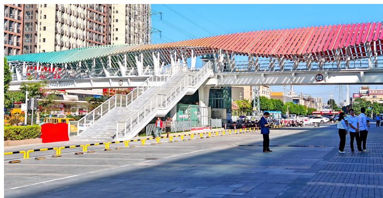
■大沥镇建设大道人行天桥启用。
