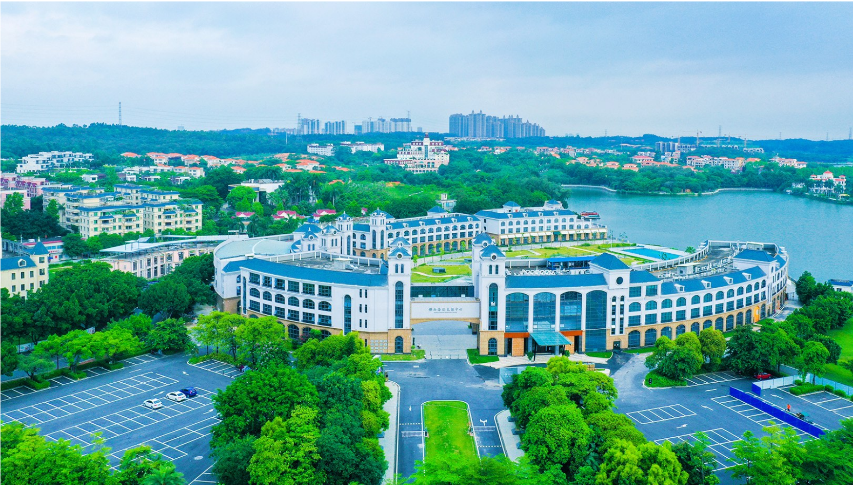
■丹灶积极布局氢能产业,全力打造“中国氢都 科创丹灶”。图为丹灶仙湖氢谷。
