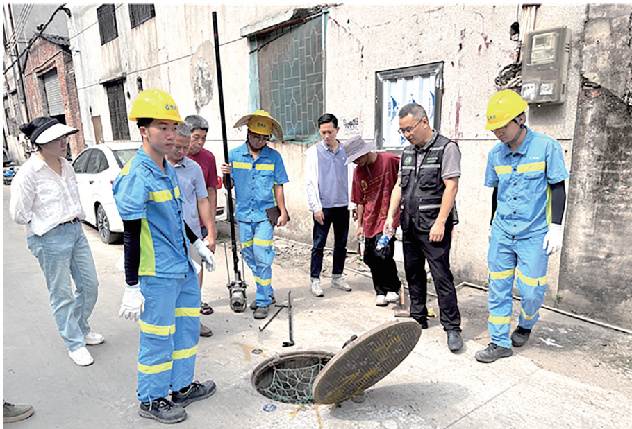
■圣堂工业区雨污分流改造施工现场。
