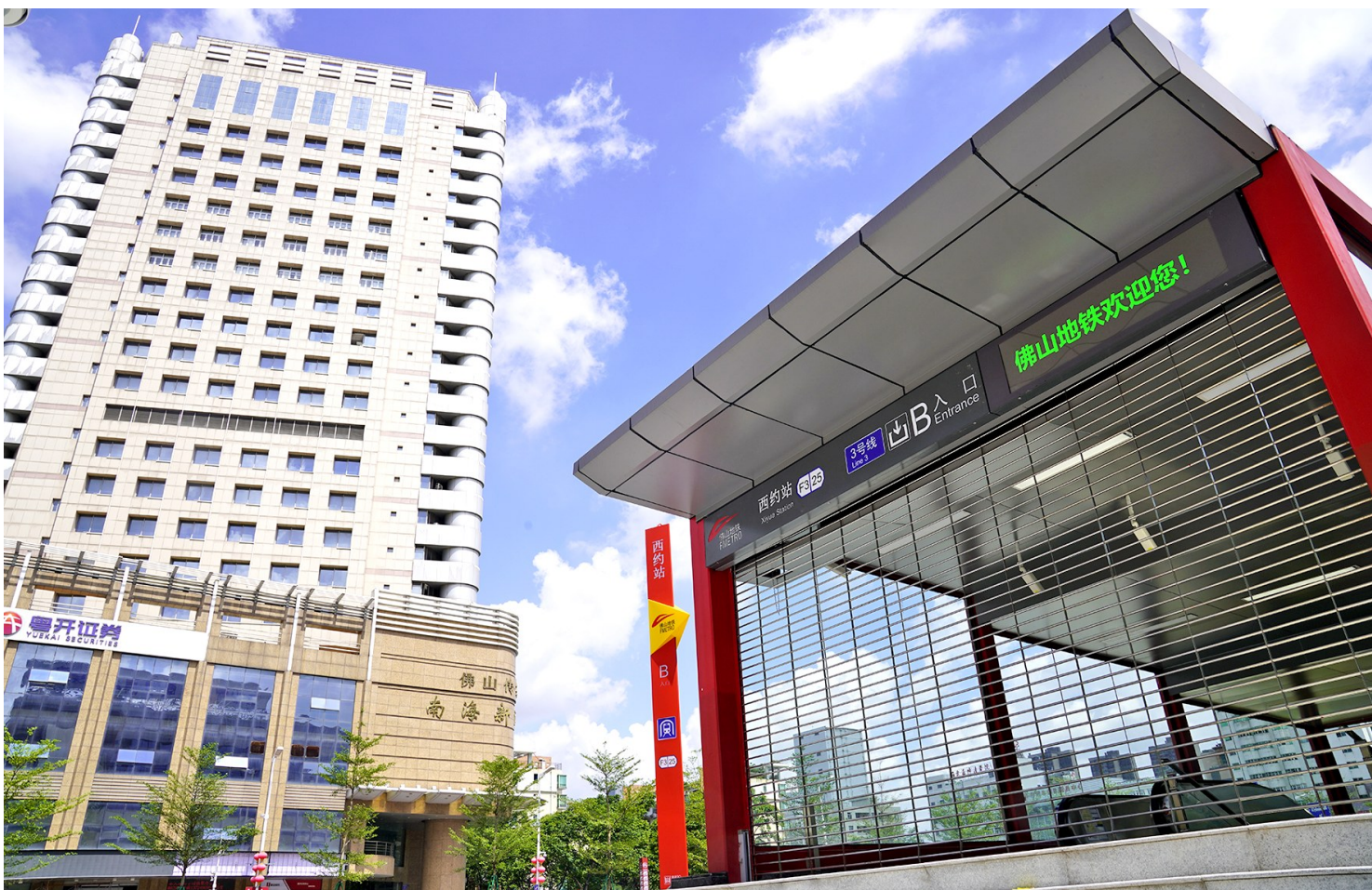
■3号线西约站B出入口。
