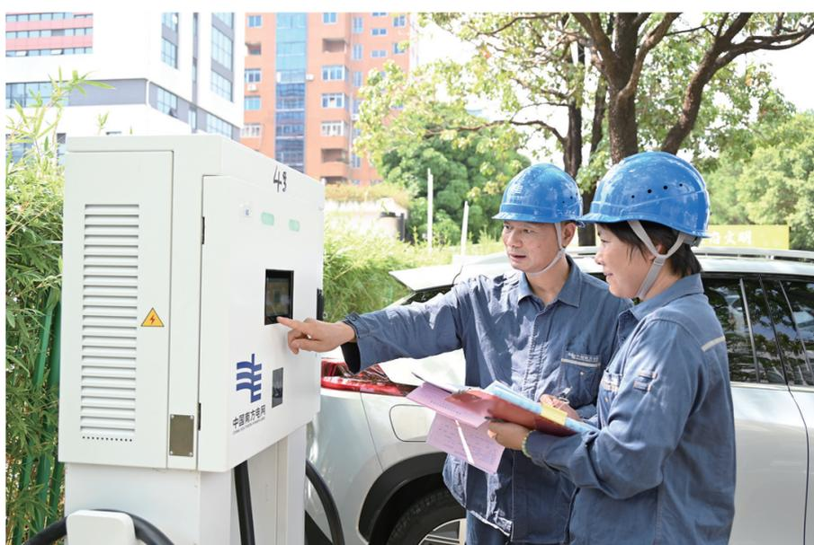
■V2G充电车位,把新能源汽车看成小型“移动充电宝”,在用电高峰时给电网送电,帮助调峰。
