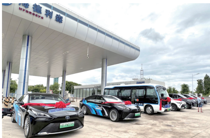
■南海丹灶海德利森加氢站。
