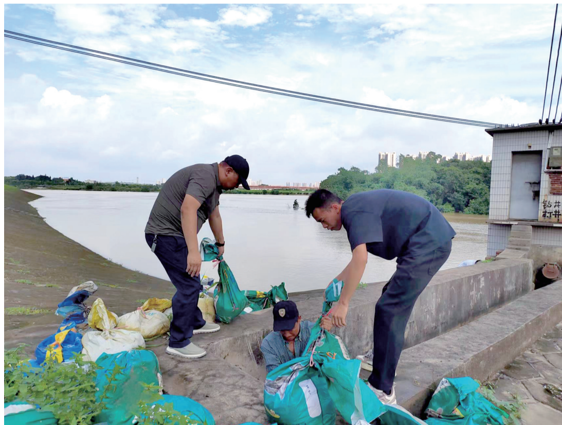
■丹灶已关闭穿堤闸42宗,图为工作人员用沙包塞闸。
