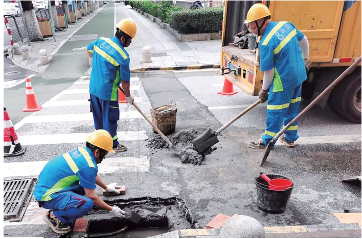
■工作人员开展排水设施维护保养及隐患排查。
