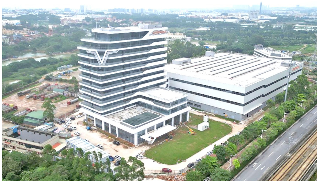
■慧谷科技研发生产总部基地即将投用。
