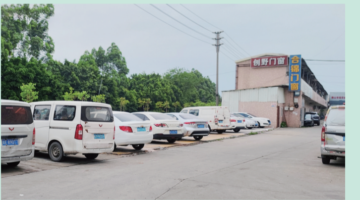
■铁锈皮屋联排店铺拆除后，还路于民。
