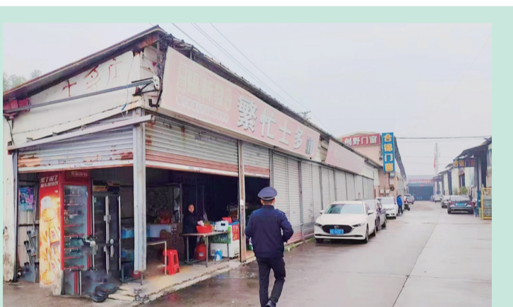
■高边社区一处铁锈皮屋联排店铺存在安全隐患。
