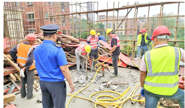
■执法人员依法拆除违法建筑。
