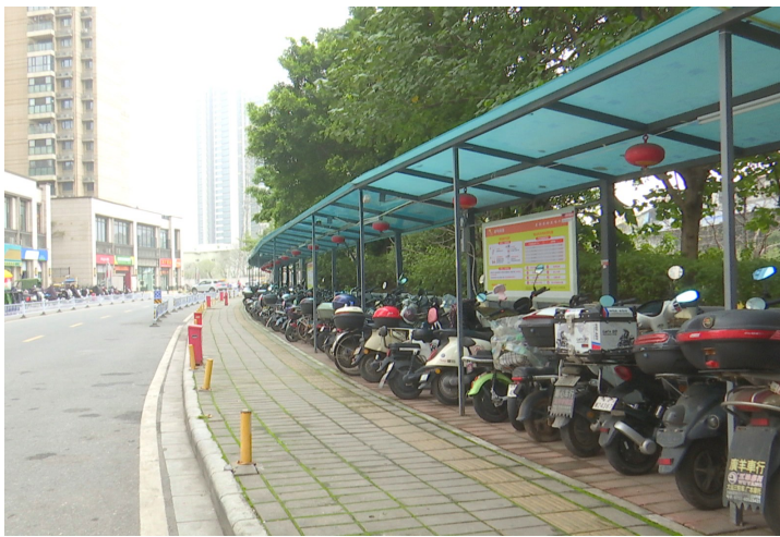
■某小区外的电动自行车充电站。
