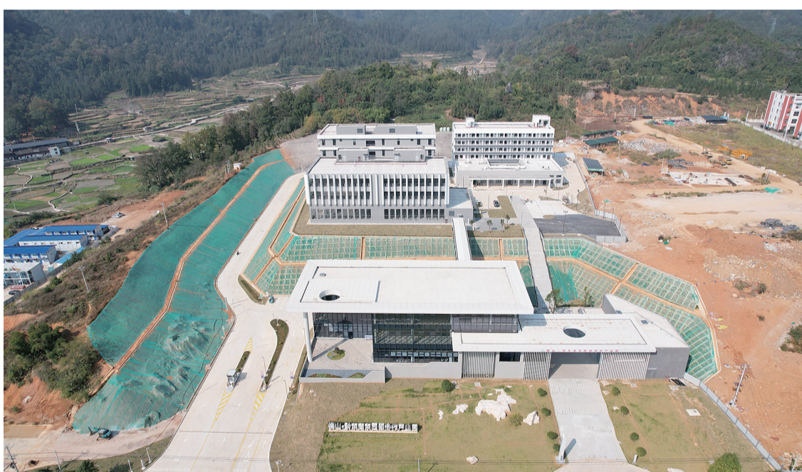
佛山(南海)—黔东南(从江)东西部协作产业园首期厂房竣工交付。(通讯员供图)
