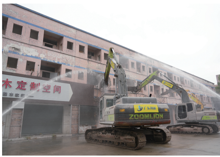
■里水拆除一批旧厂房,提速广佛西环里水段建设。
