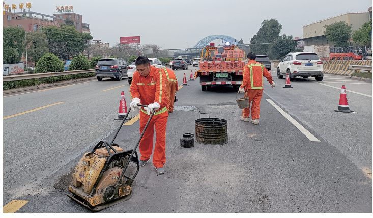
■彭铁标和同事在填补公路的坑洞。
