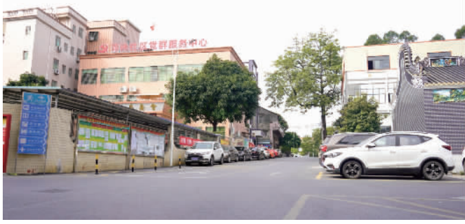
■铺上沥青的邓岗环村路平整宽阔。
