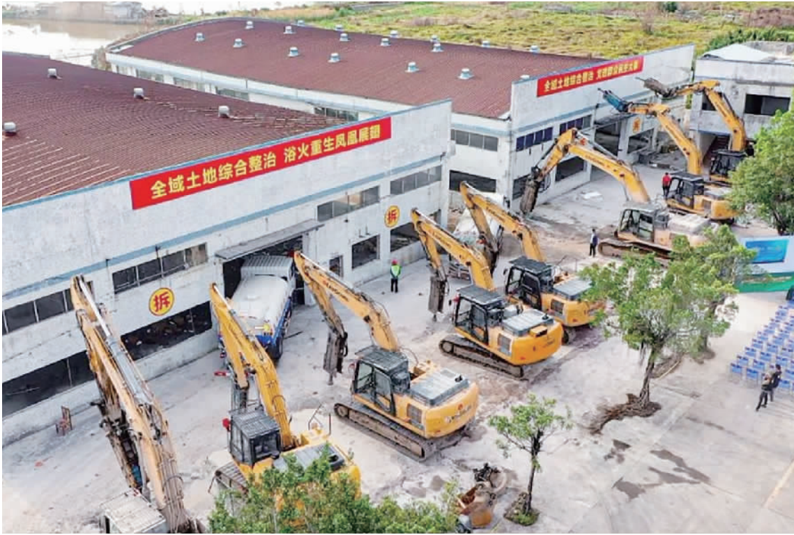
■里湖新城福南湾建设用地腾退项目拆除现场。
