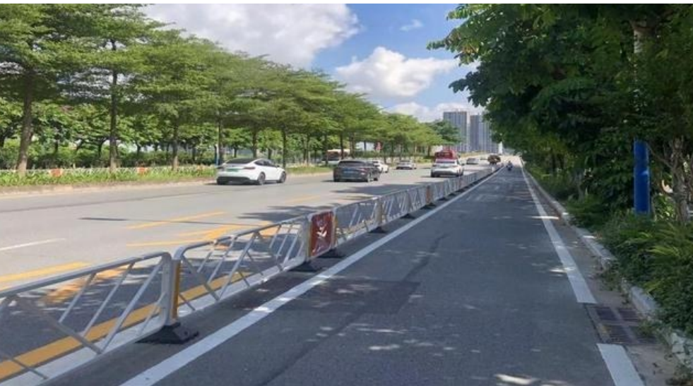
■联河大桥新增设的非机动车道。
