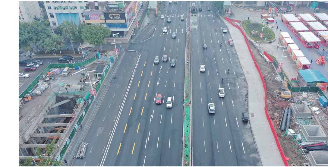
■南海大道全线恢复通车。
