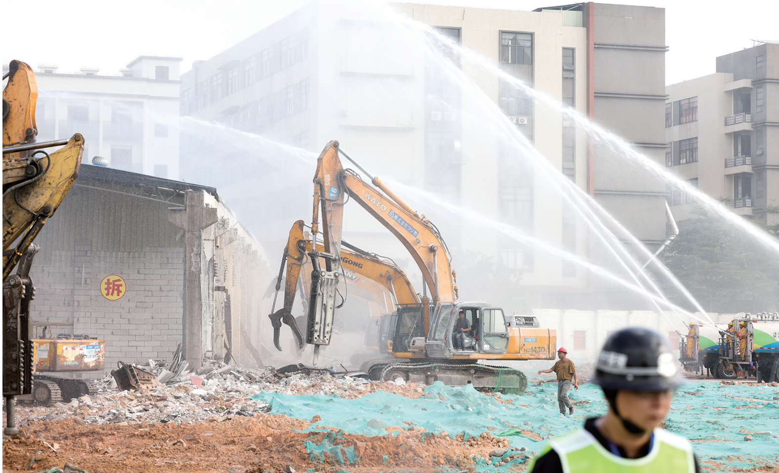
■现场会上,钩机出动拆除旧厂房。
