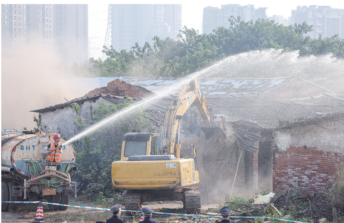
■狮山镇石碣社区孙岗工业园改造项目拆除现场。
