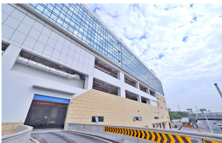
■南海区人民医院公交枢纽是全市首个“综合利用开发”公交枢纽。 佛山市新闻传媒中心记者/黄永程 摄
