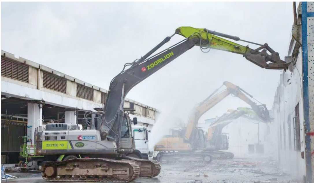
■唐边村级工业园改造项目清拆现场。
