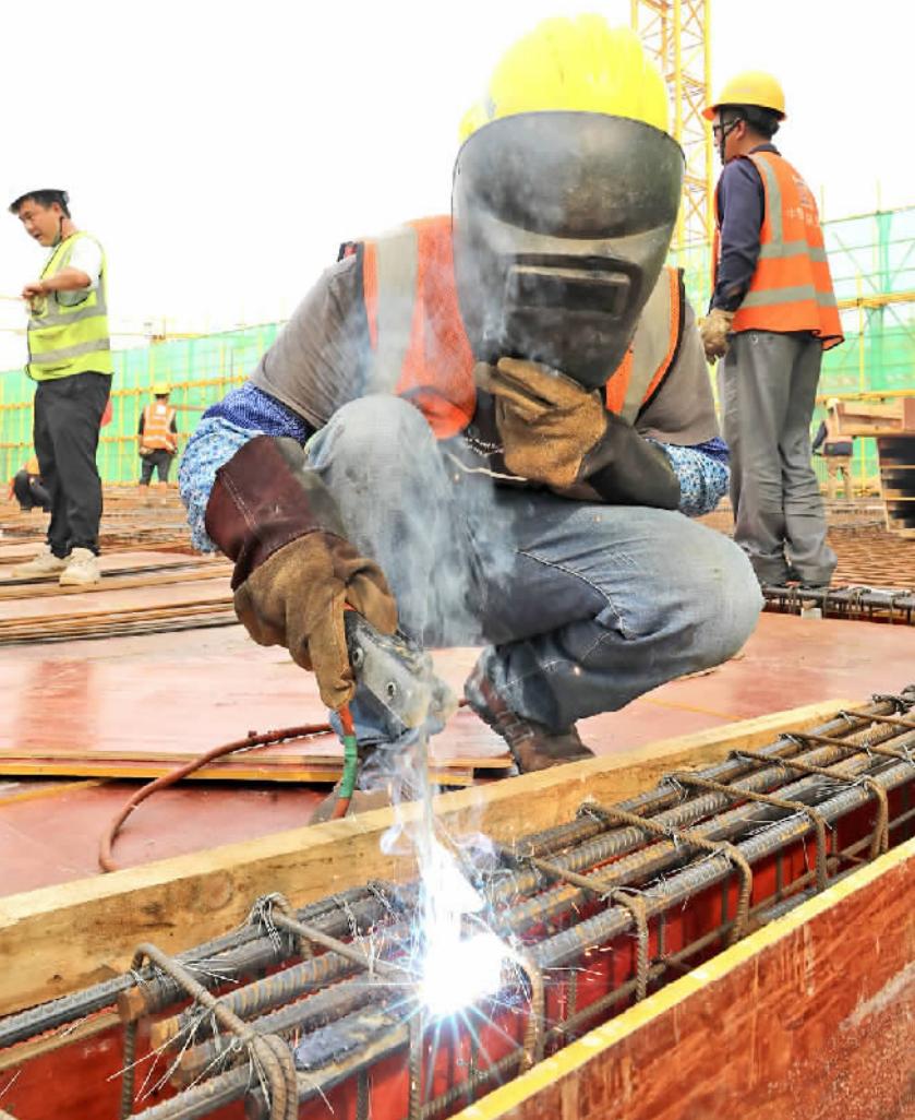
■电焊工人在高温天气下焊接。
