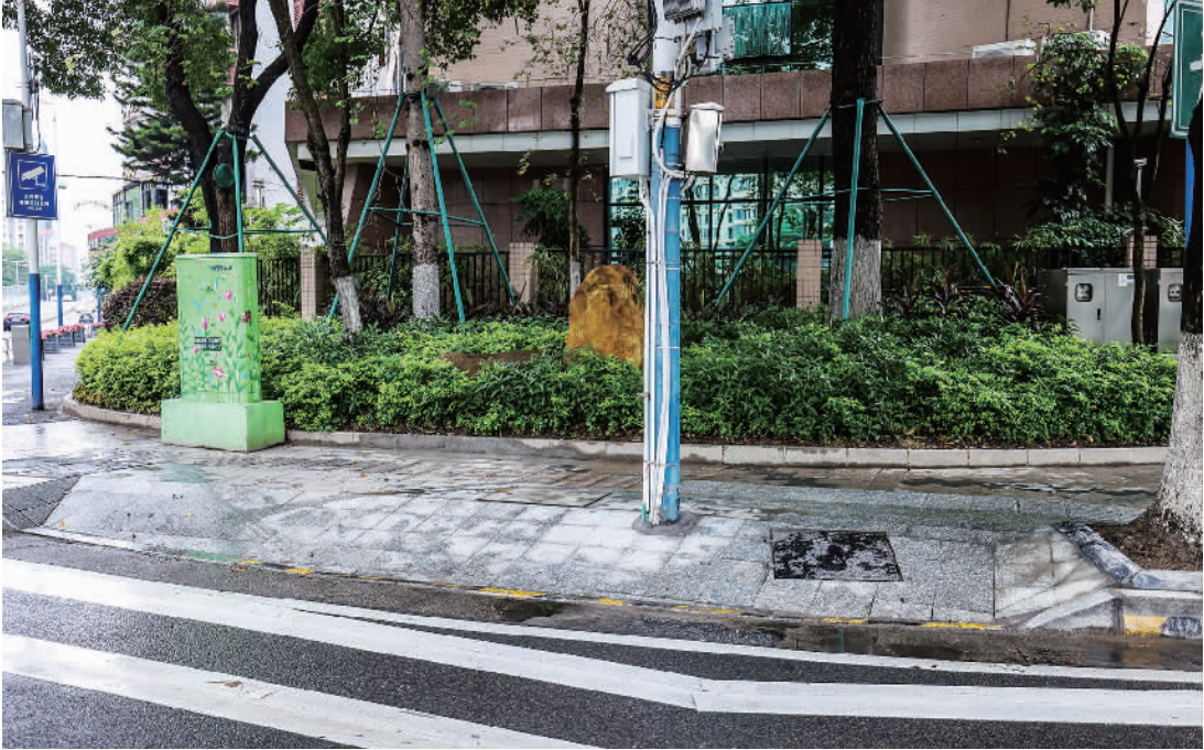
■南海大道南新三路路口通过移除机箱和下沉阶梯,增加市民通行效率。
