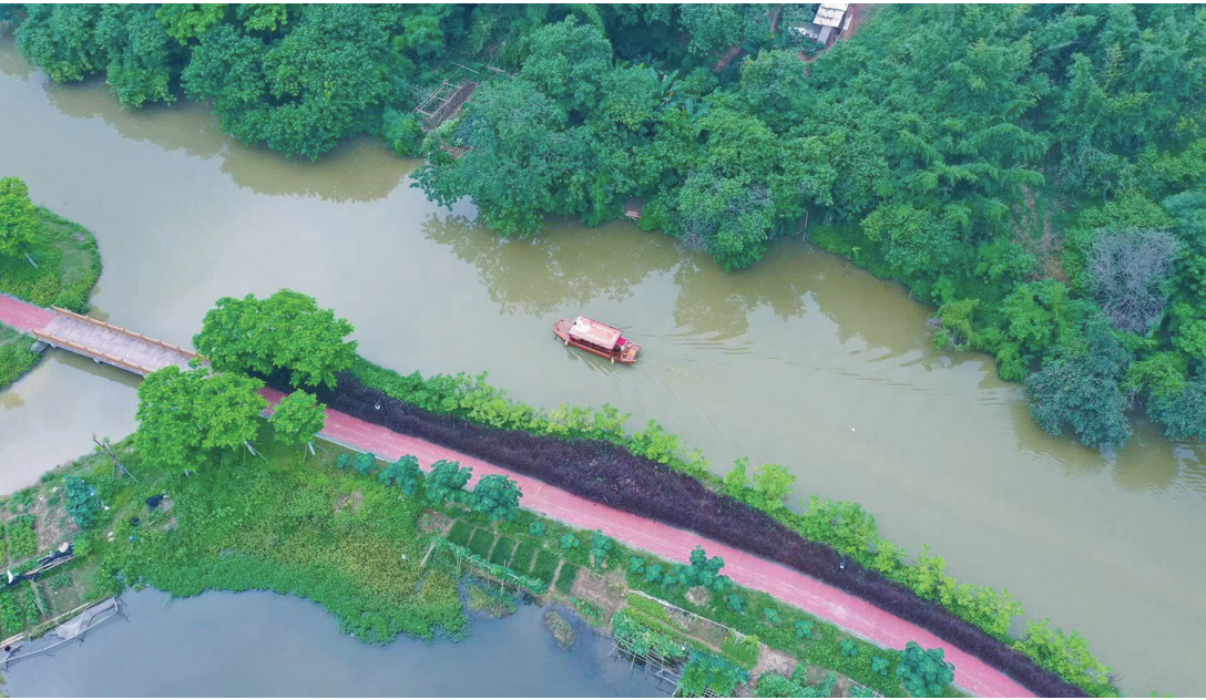
■丹灶有序推进水环境科学治理,水环境不断提升。图为有为水道。
