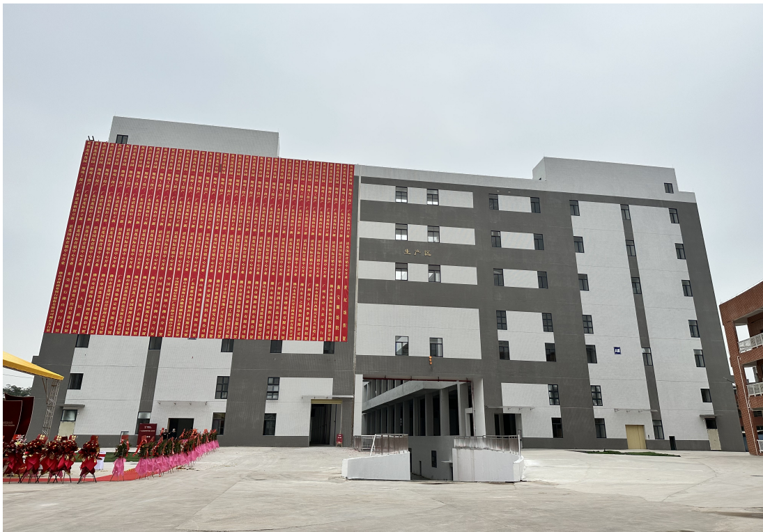
■广东滔莲转型升级示范项目竣工投产。
