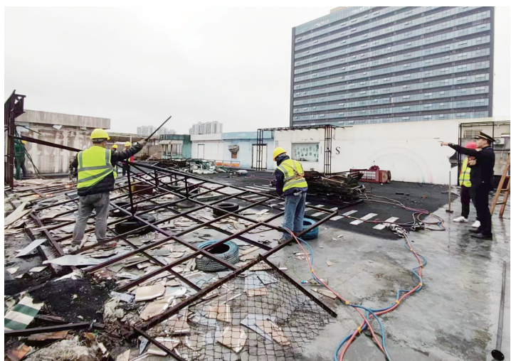
■执法人员拆除桂雅社区某工业园楼顶违建。
