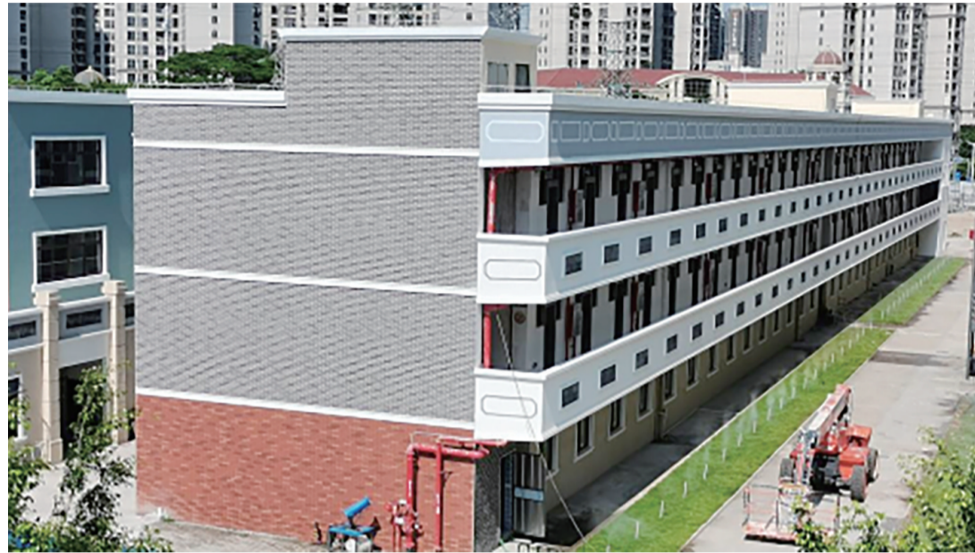
改造后的德鸿文汇创意园二期项目。
