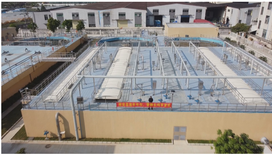
■里水镇和桂工业园污水处理厂。
