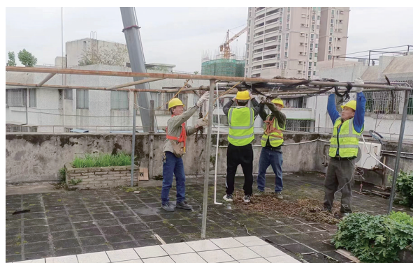
■施工队清拆楼顶违法建设。通讯员供图
