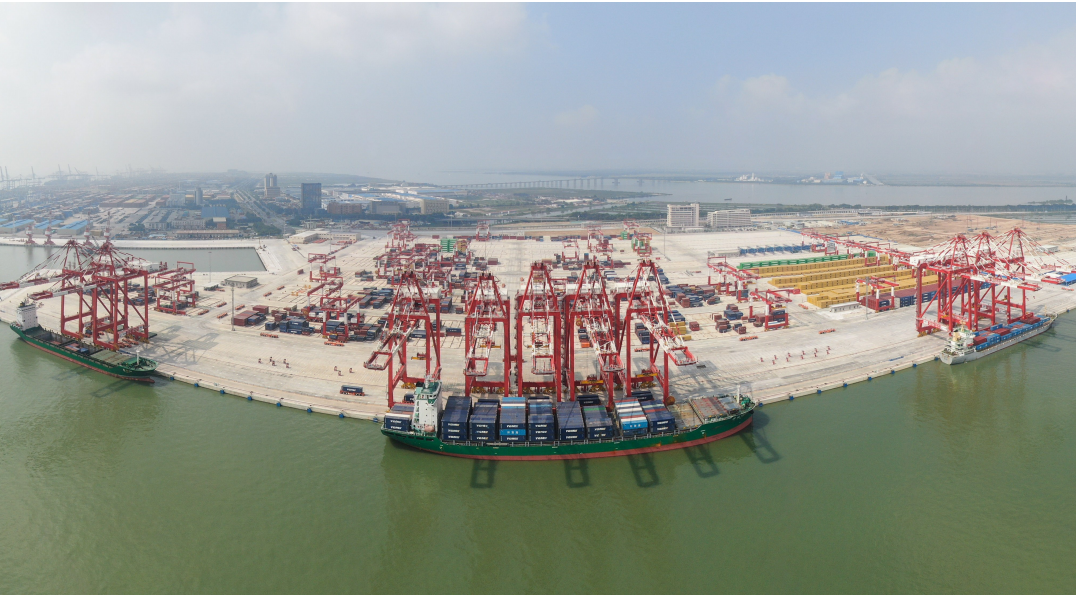
■广州港南沙港区四期全自动化码头。
