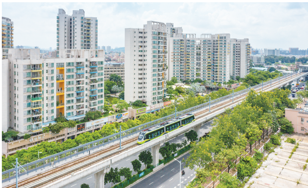
■南海有轨电车一号线。
