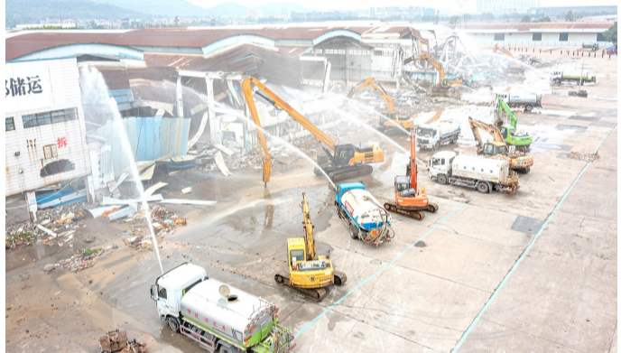
2022年1月，西樵镇开展全域土地综合整治暨三大万亩“工改工”项目拆除大攻坚。
