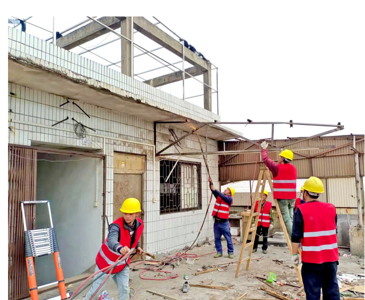
■施工人员清拆楼顶违建。
