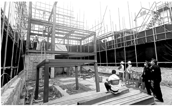
■对违法加建进行拆除。 通讯员供图
