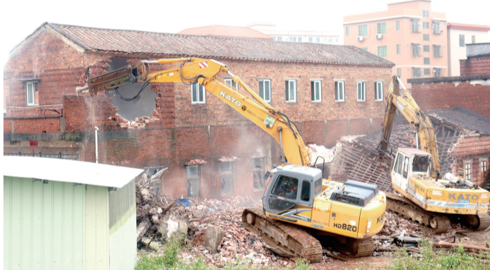
行动中,丹灶对违法建筑进行拆除。
