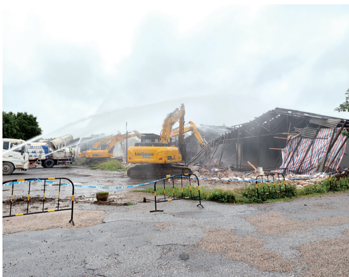
大沥香基河岸约5500平方米老旧厂房被拆除。
