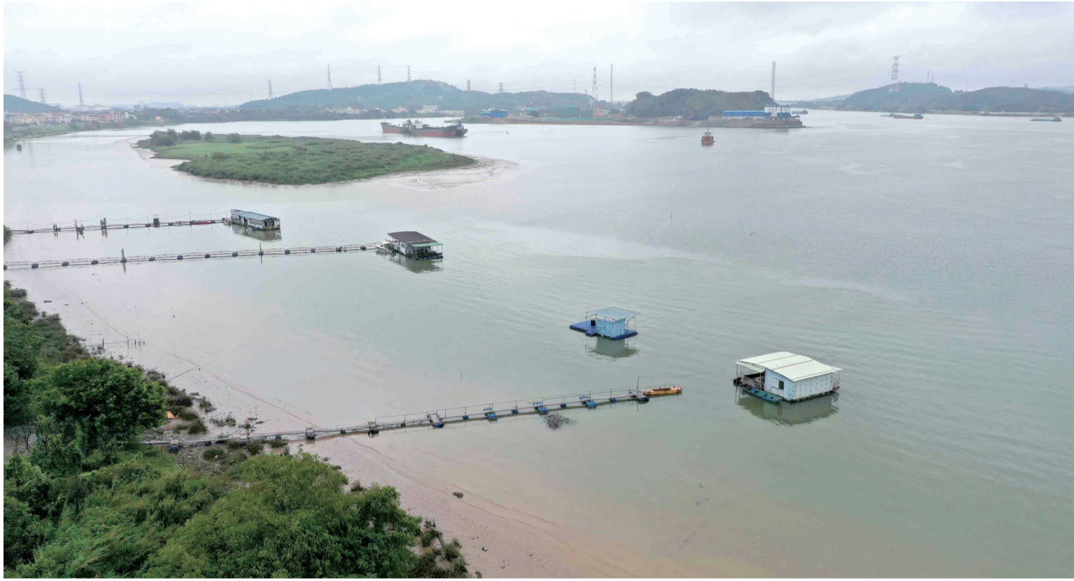
在九江,西江岸侧非法搭建的船舶引桥在本次行动被清拆。
