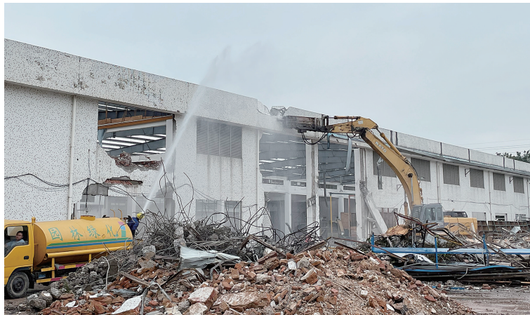
钩机正在拆除豹王集团旧厂房。
