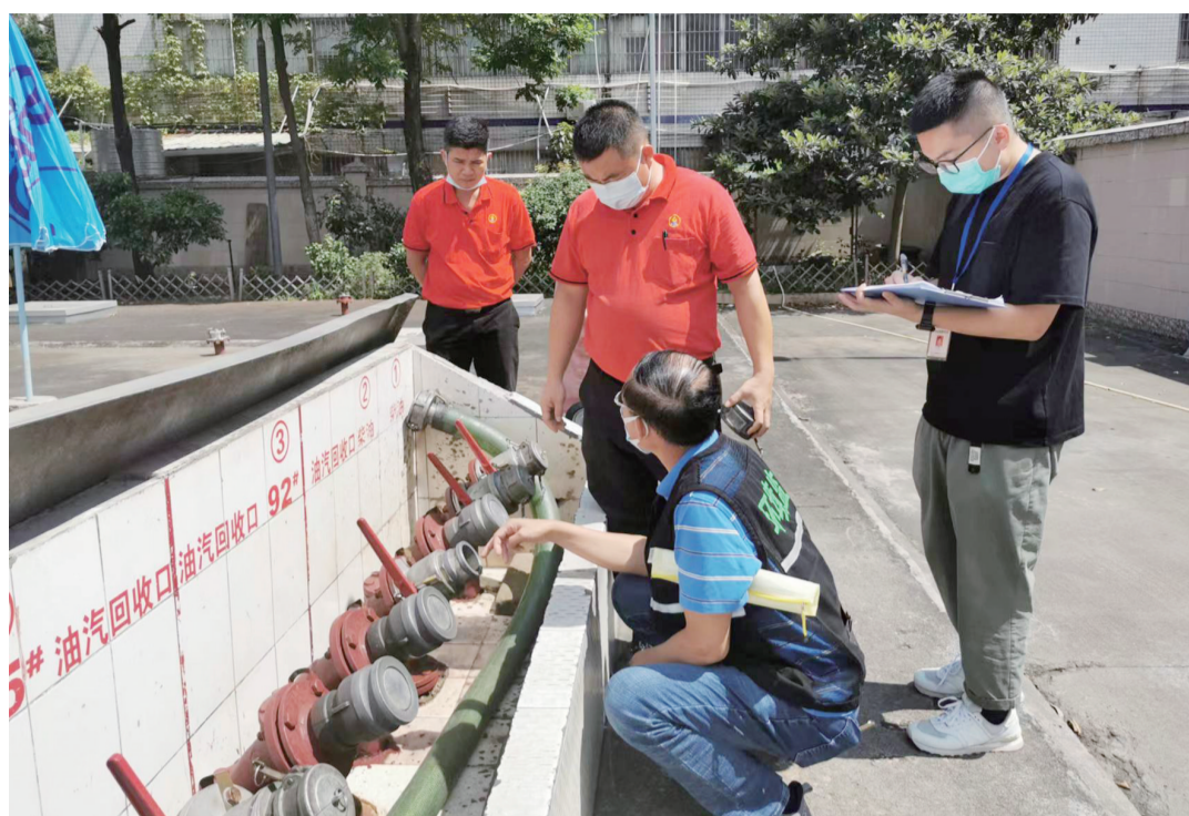
南海区环保执法人员检查加油站油气回收设施。
