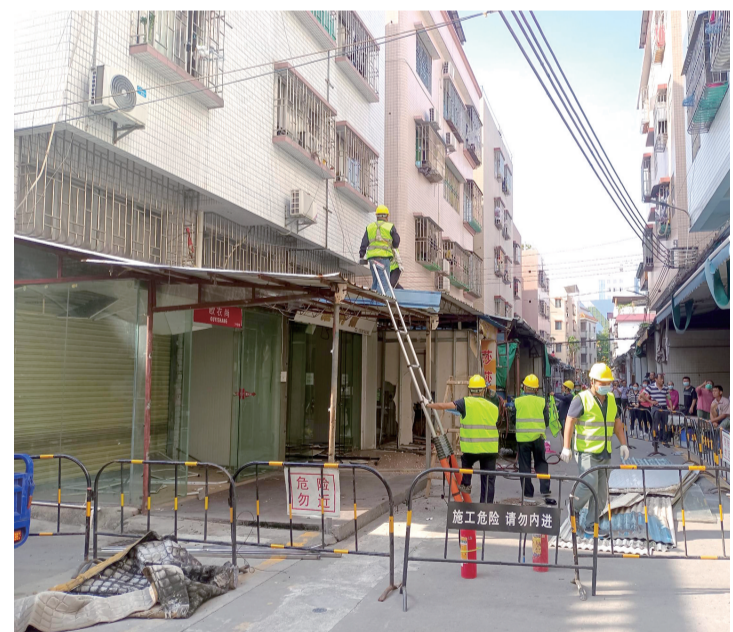
■施工队拆除沿街违规搭设的雨阳棚。
