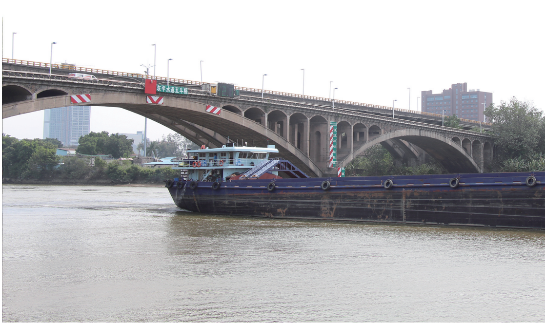
■旧五斗大桥桥上桥下车水马龙。
