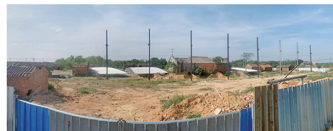
违建铁棚架已被拆除。 通讯员供图
