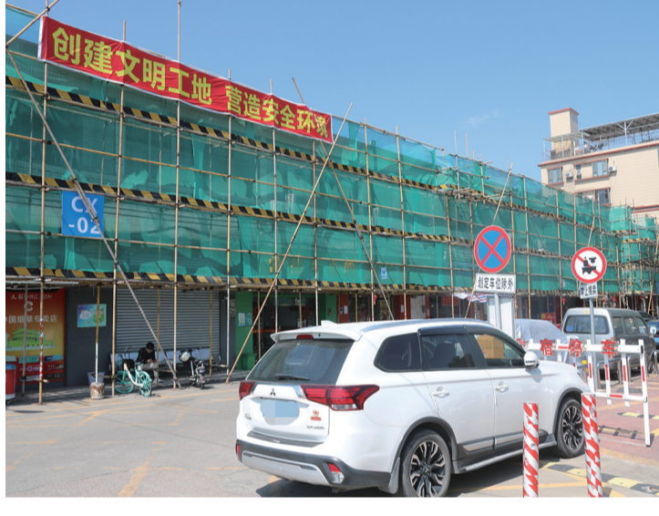
机场周边环境整体提升工程目前正在施工。
