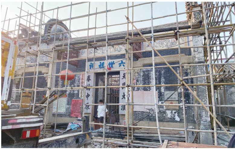
■季房六世祖祠修缮中。
