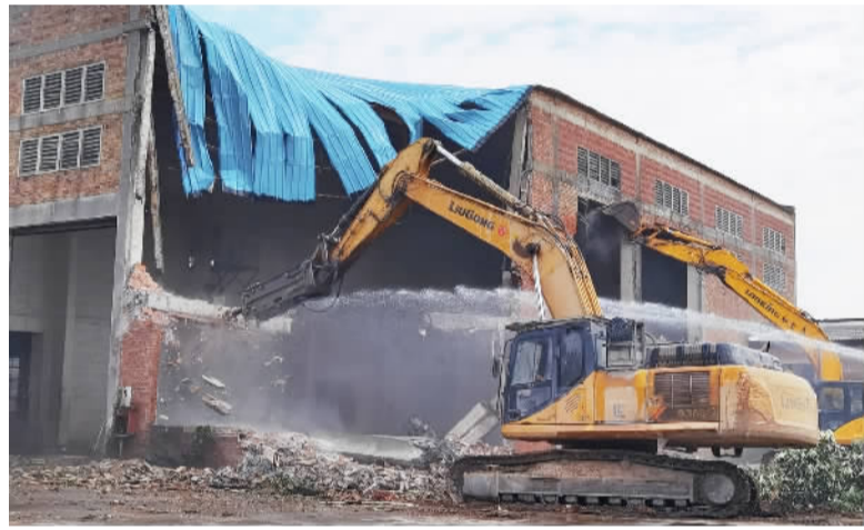
钩机进场拆除旧厂房。
